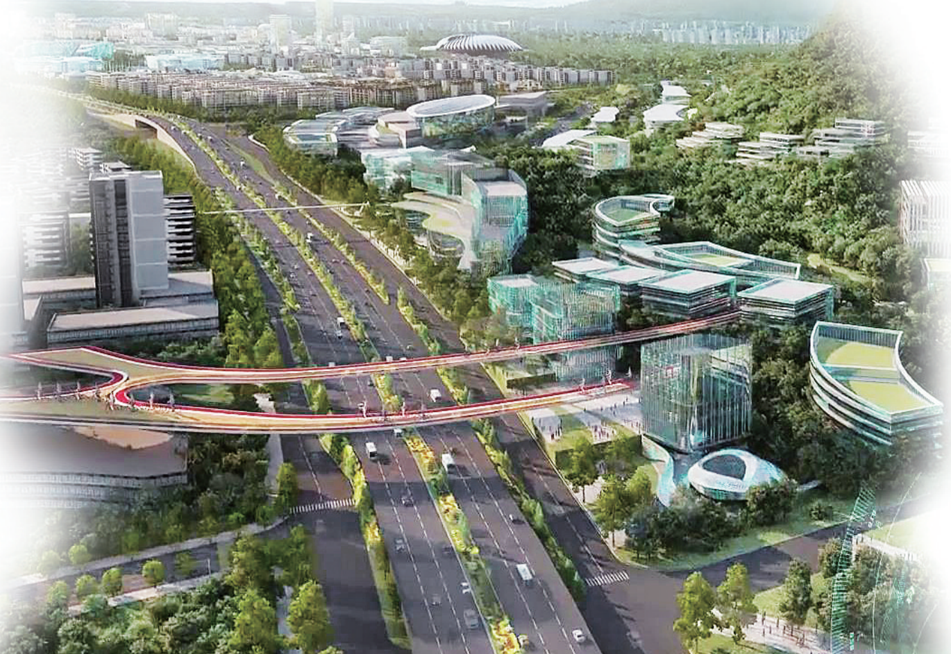
科学城立体交通网络(一期)包括大学城复线隧道、白市驿隧道、轨道7号线等重点基础设施项目建设。
