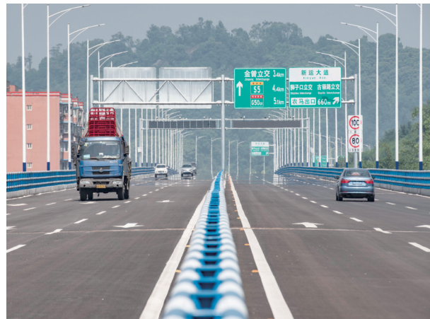
华岩隧道西延伸段主线，车辆在路面上行驶。
