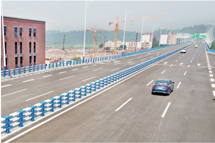
华岩隧道西延伸段。
