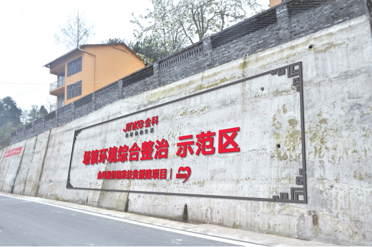
金科在石柱县打造的场镇环境综合改造工程
