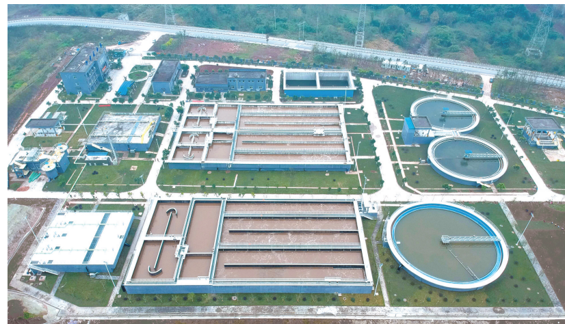
重庆水土污水处理厂二期工程
