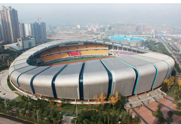
重庆南川体育场工程(中国钢结构金奖)
