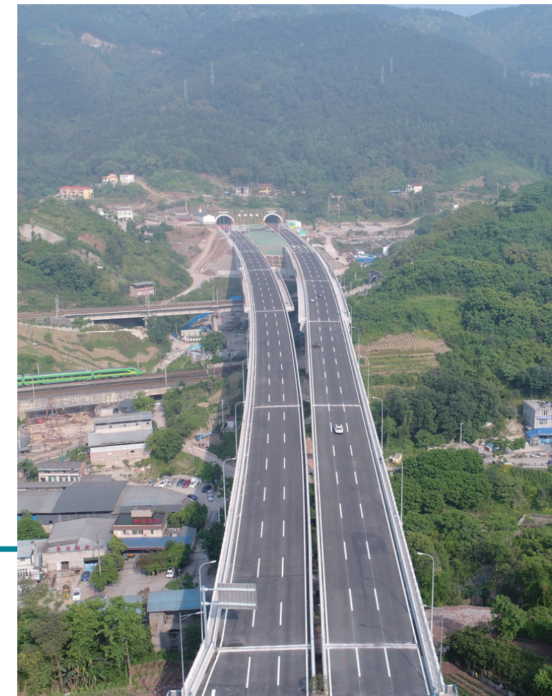
重庆歇马隧道东西干道工程
