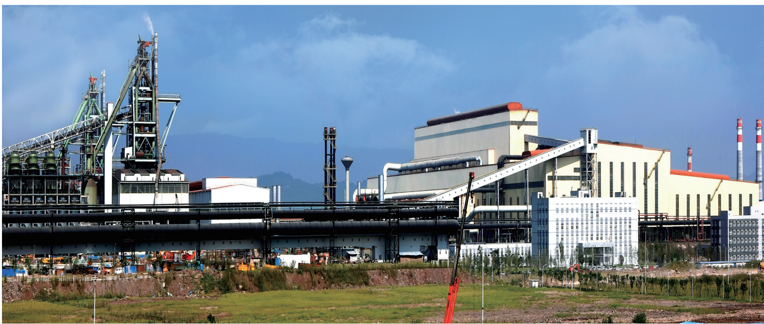
重钢环保搬迁工程
