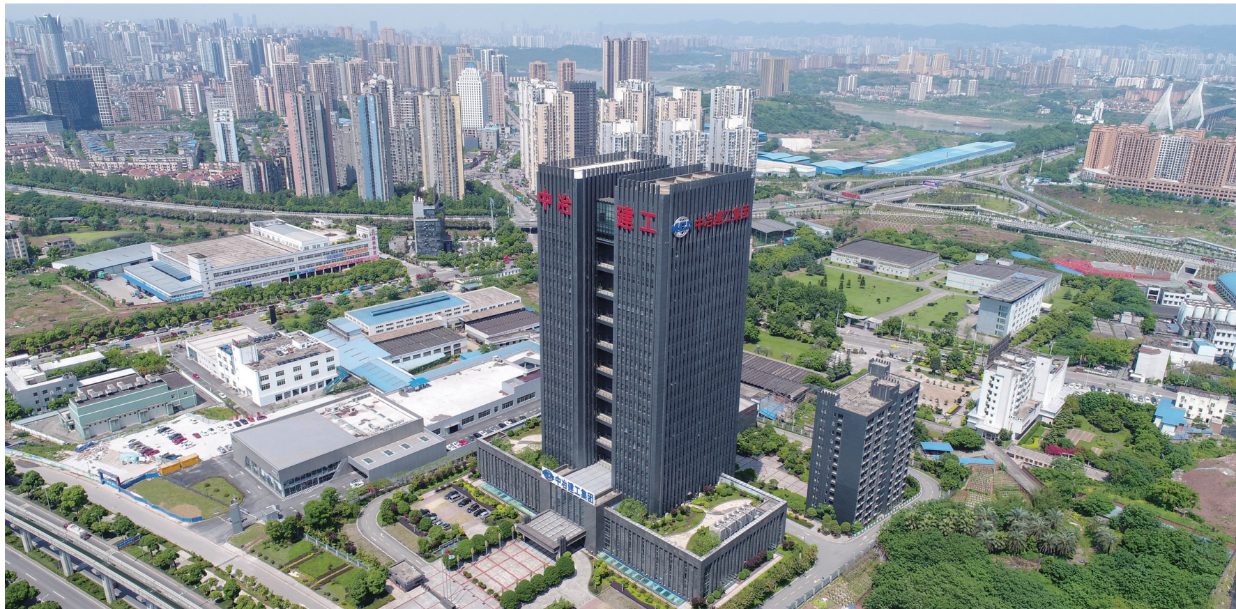
中冶建工大廈工程(中国建筑工程鲁班奖)
