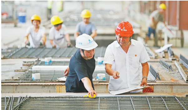
8月10日,魏祖平(右)在生产车间查看混凝土预制件生产情况。
