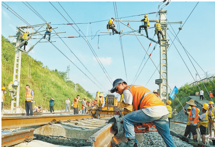
▲八月十日,新建渝怀铁路二线涪陵至中嘴段,铁路工人正在进行线路拨接施工。 首席记者 崔力 摄/视觉重庆
