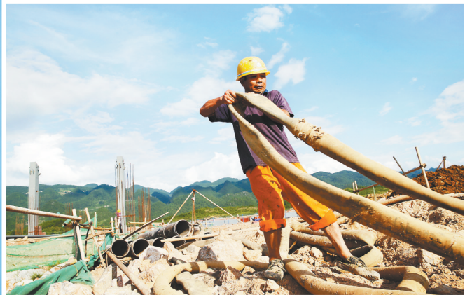
▼8月6日,工人在黔江武陵山机场扩建工程工地施工。 特约摄影 杨敏/视觉重庆
