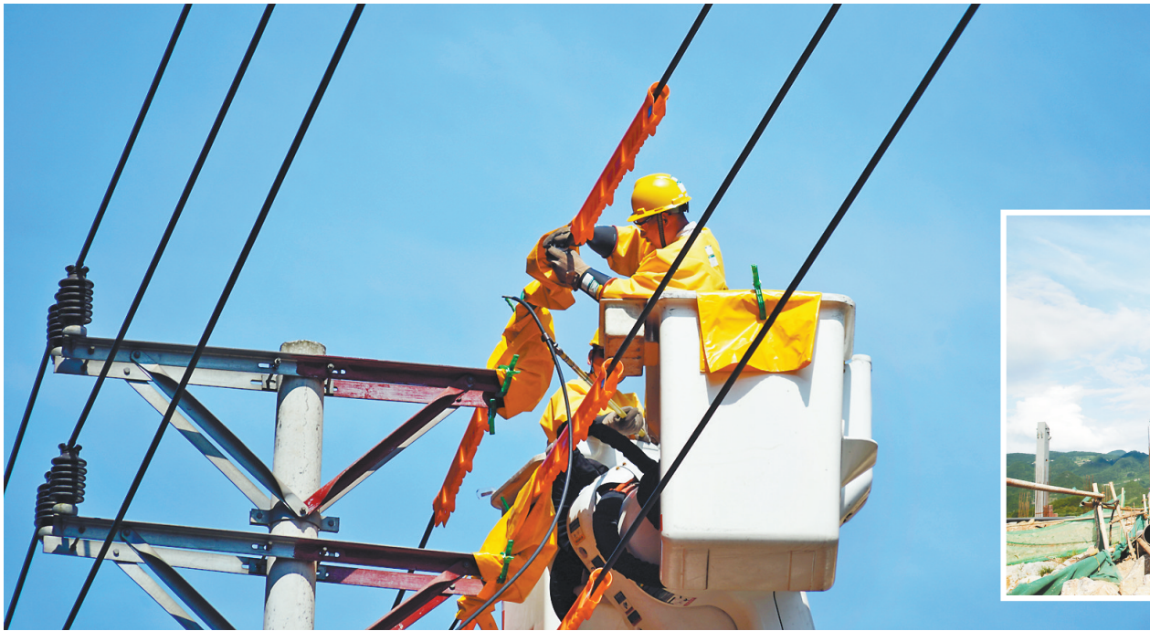
▲8月3日,国网重庆市电力公司潼南区供电分公司员工在室外进行带电作业。 通讯员 李旭 摄/视觉重庆
