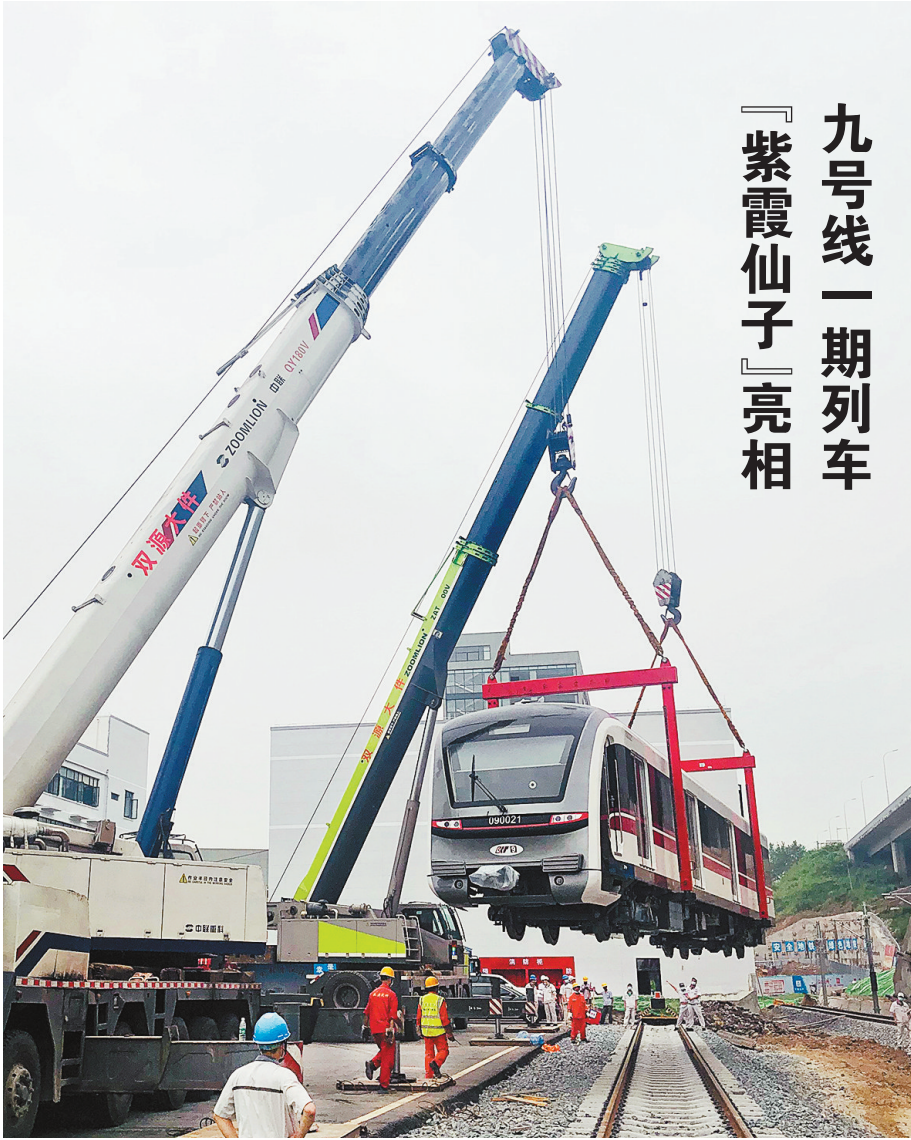
九号线一期工程首列车来了!7月30日上午,身穿白色“制服”、系着紫红色“腰带”的“紫霞仙子”列车,正式亮相九号线一期台商车辆段现场。
