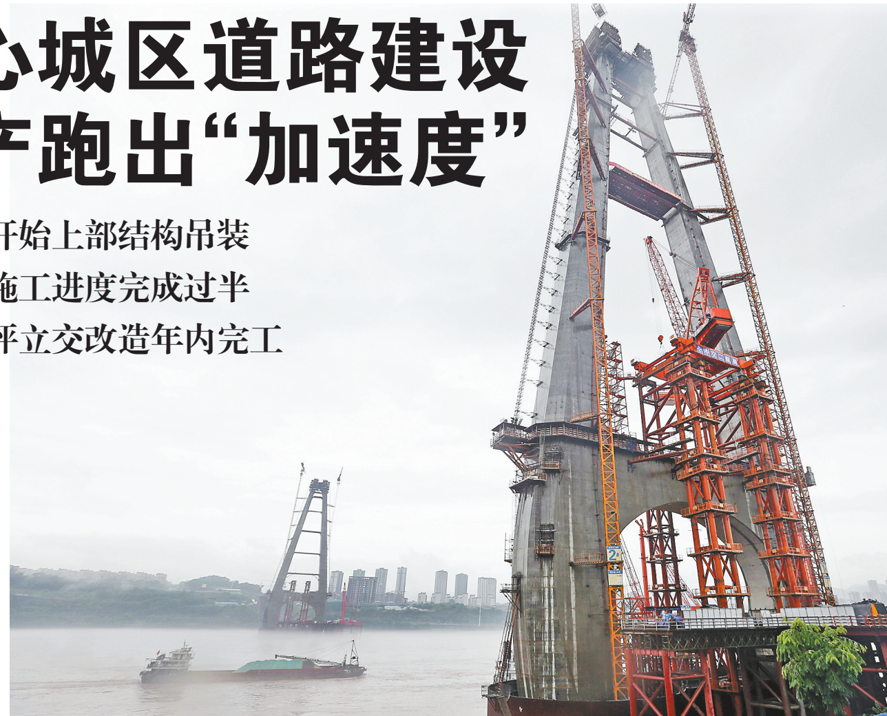
梁斜拉桥主桥开始上部结构施工。 七月一日上午,白居寺长江大桥主桥钢桁梁首根杆件起吊,标志着世界最大跨度的公轨两用钢桁
