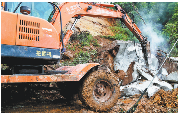
6月28日,江津区蔡家镇,工作人员正在疏通被滑坡阻断的公路。通讯员 侯祥 摄/视觉重庆
