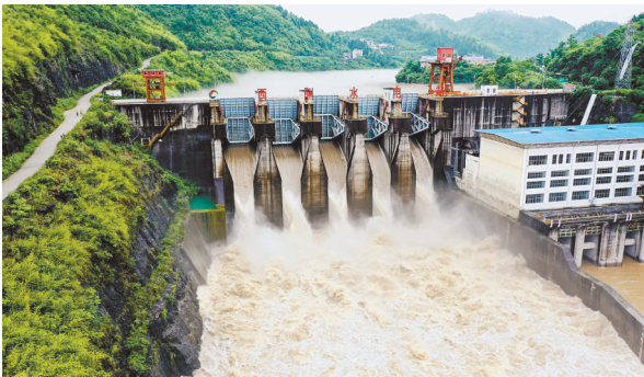
6月28日,酉阳酉酬水电站开闸泄洪。
