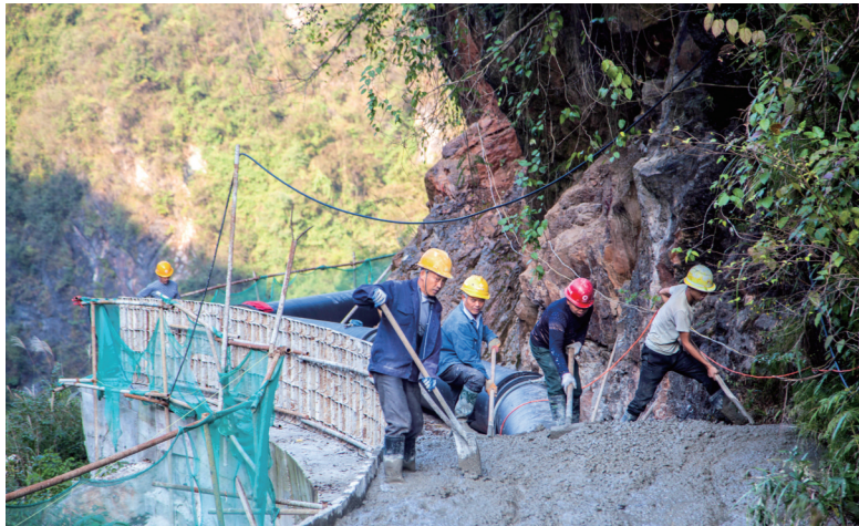
秀山县农村饮水安全联网工程兴隆垭段施工现场
