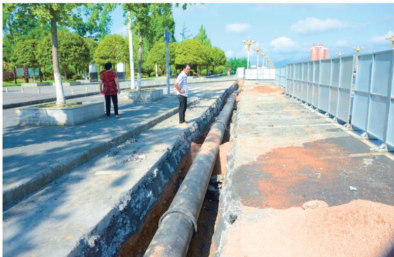
秀山第三水厂入城管线铺设
