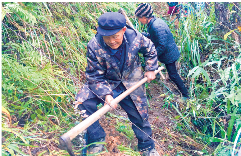
兰桥镇官舟村村民在铺设自来水管
