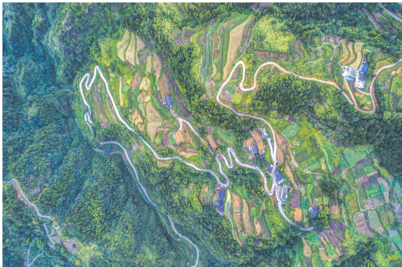
金溪镇产业路
