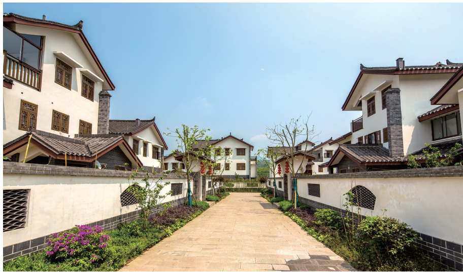
大盛镇青龙村。在大盛镇青龙村6社太和场农村人居环境整治示范点，这里原有30家农户，房屋多以土墙为主，室内简陋破败，厨房狭小、黑暗，有些房屋木梁已经断裂，仅靠木棍支撑。2018年以来，大盛镇参照川东民居建筑风格，打造了一个前庭后院、高低错落、依山傍水的乡村建筑群，极大地改善了当地村民的生活环境。
