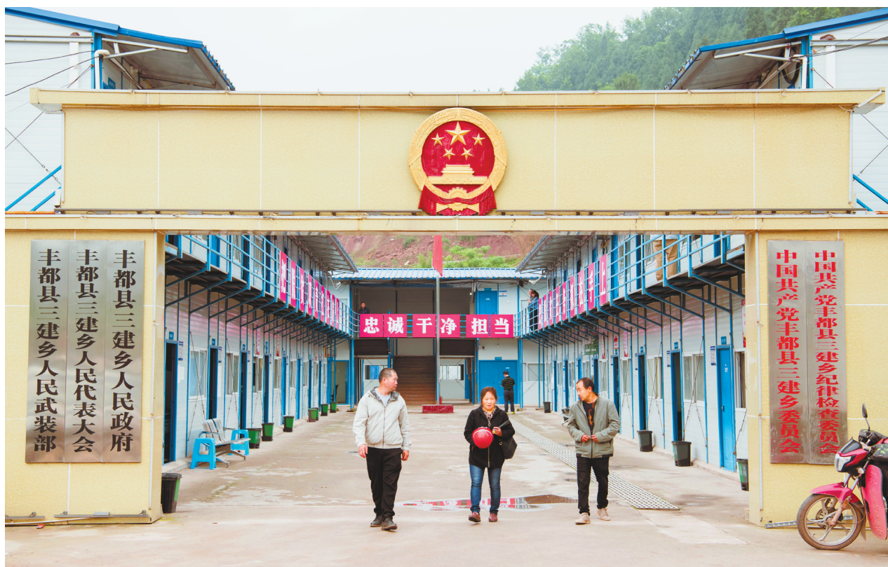
五月十一日，丰都县三建乡政府的板房办公楼。
