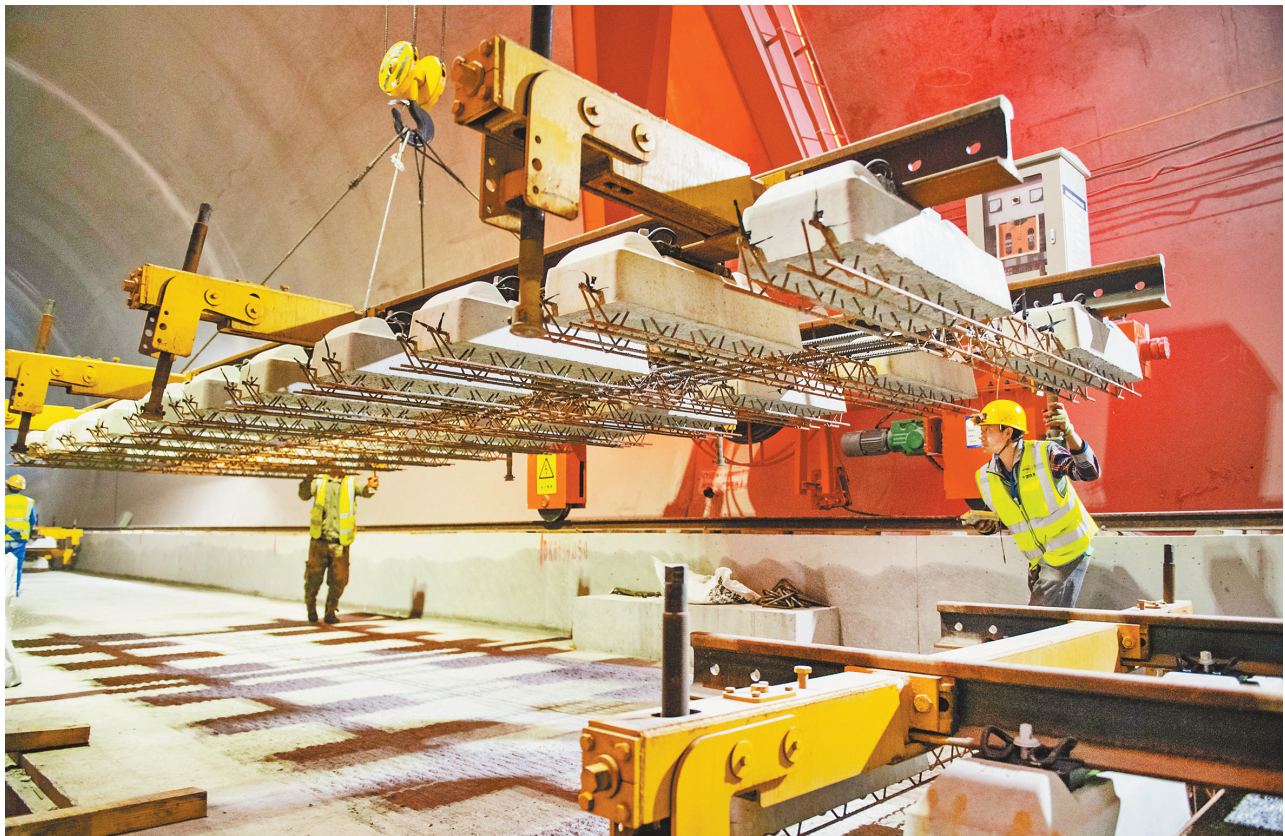
4月21日,郑万高铁万州天城隧道施工现场,工人正在铺设无砟轨道。
