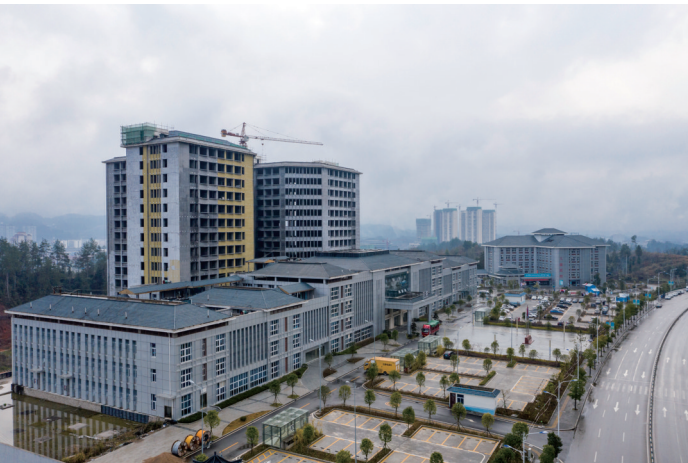
建设中的重庆市黔江中心医院正阳院区
