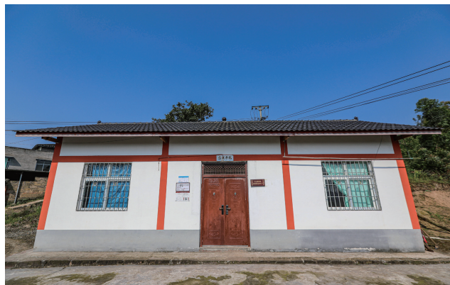
中山路街道孙家口村危房改造 摄/陈科儒
