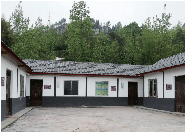
金龙镇洞子口村彭家寨村民小组危房改造
