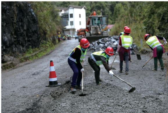
彭水省道S522梅子堰镇至桑柘镇路,工人对软上路基进行换填补强处理
