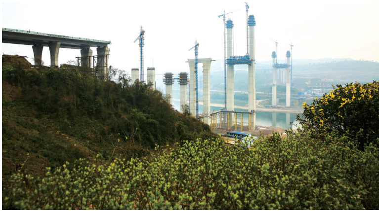
市级重点交通建设项目嘉陵江蔡家大桥加快建设。摄/秦廷富
