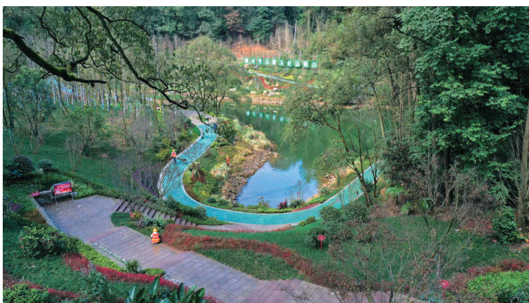
在缙云山黛湖生态修复工程现场,施工人员进行作业。摄/秦廷富
