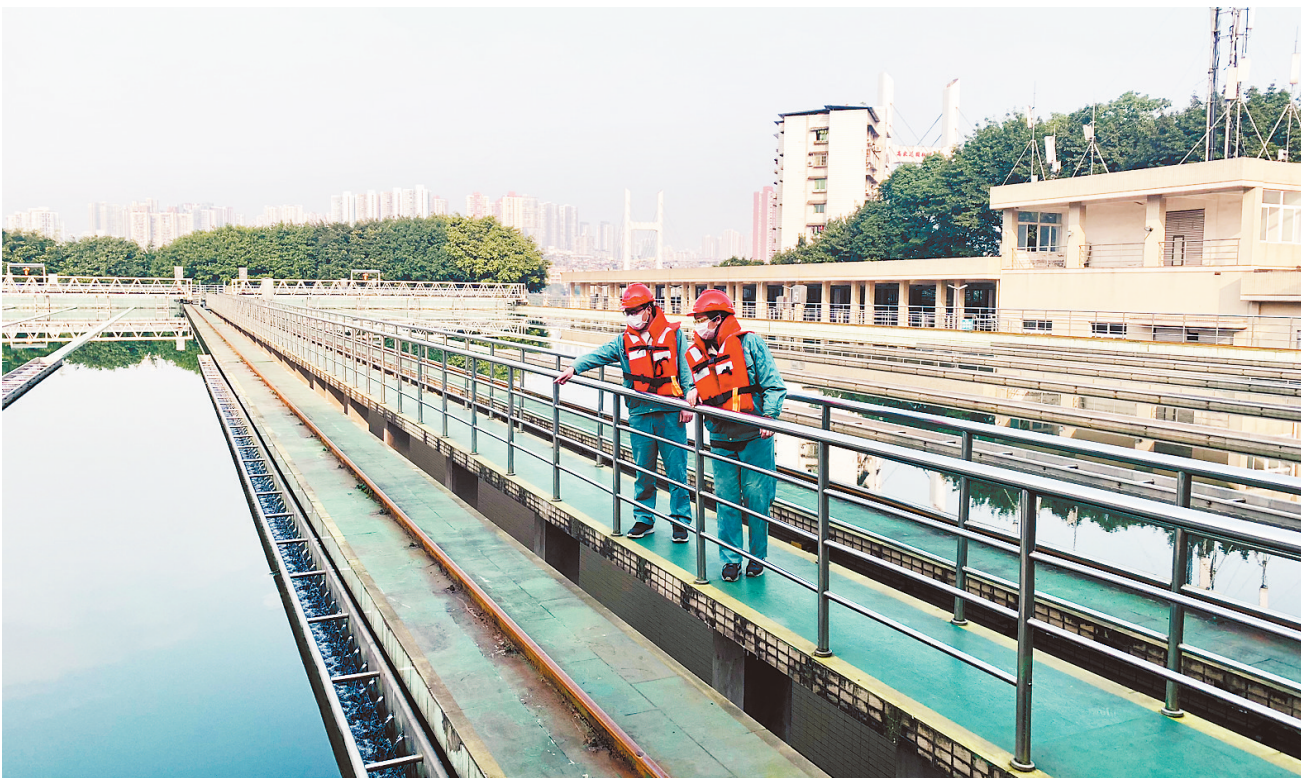
疫情防控期间，重庆水务集团加强生产巡检，全力保障安全优质供水。
