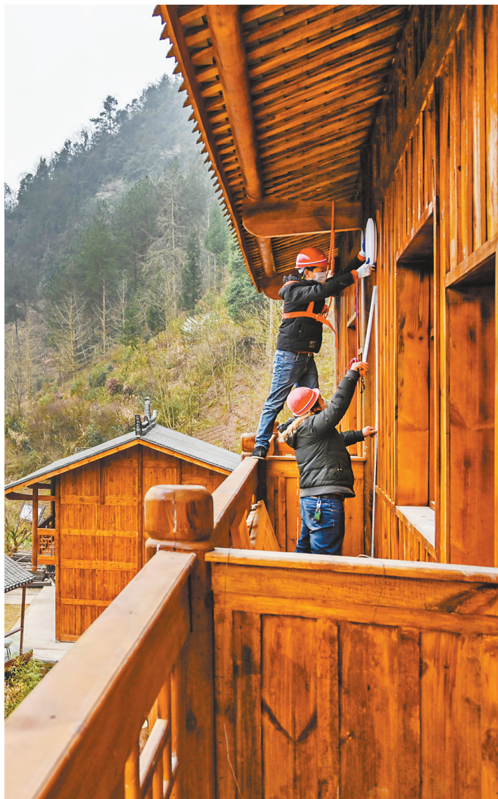
▲2月24日,为发展乡村旅游业,大湾民宿施工现场,工人们正加紧进行外立面装饰。
