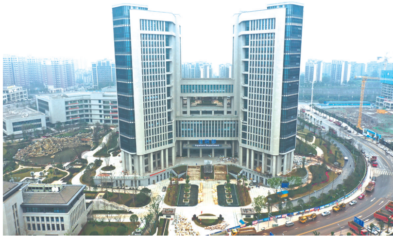
巴南区人民医院新院区
