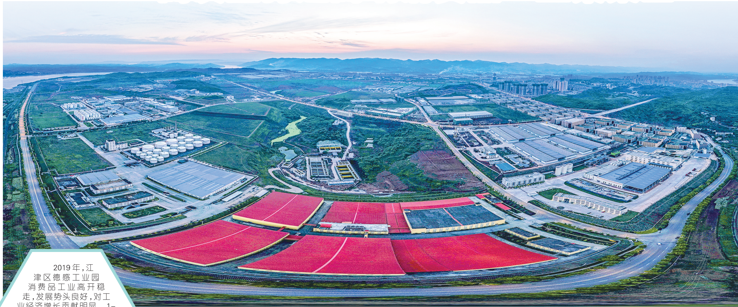
江津德感工业园粮油食品产业园一角 摄/谭文奇
