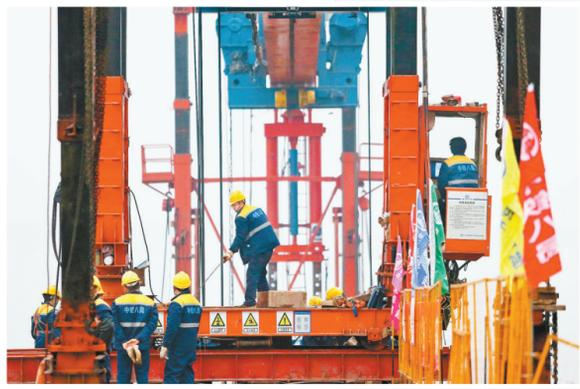
▲2019年12月31日,在重庆铁路枢纽东环线麦场湾双线特大桥桥墩上,首片预制T梁精确落位,标志着全线正式进入铺架阶段。
