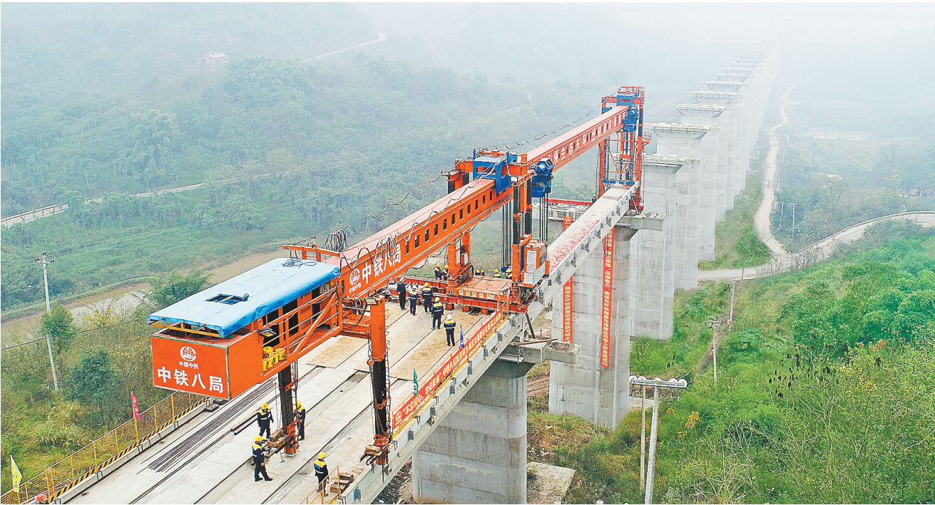
2019年12月31日，在重庆铁路枢纽东环线麦场湾双线特大桥桥墩上，首片预制T梁精确镶嵌，标志着全线正式进入铺架阶段。
