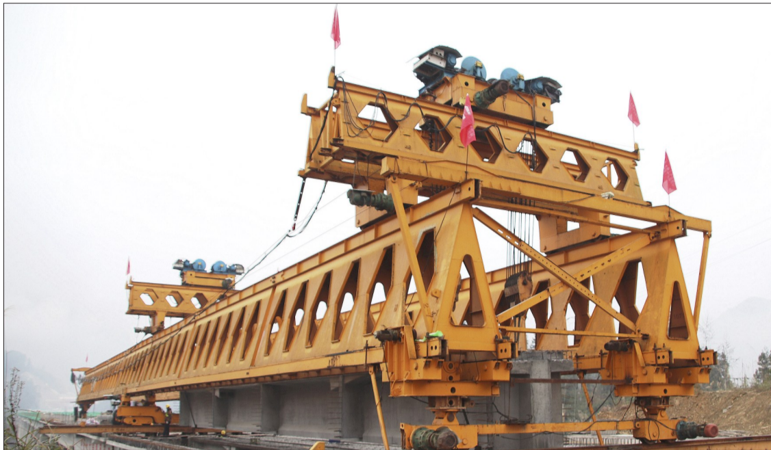
最后一片T梁架设中。
