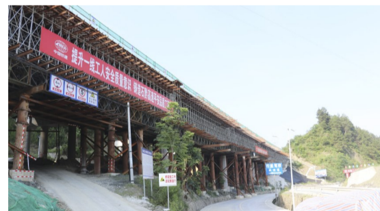
建设中的石黔高速册山枢纽互通立交。
