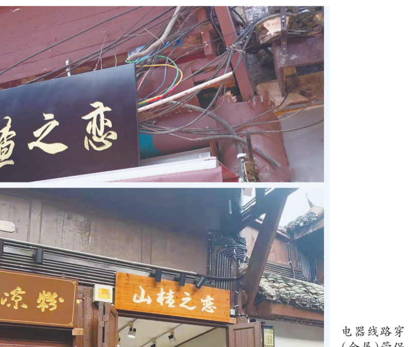
电气线路穿(金属)管保护前后对比
