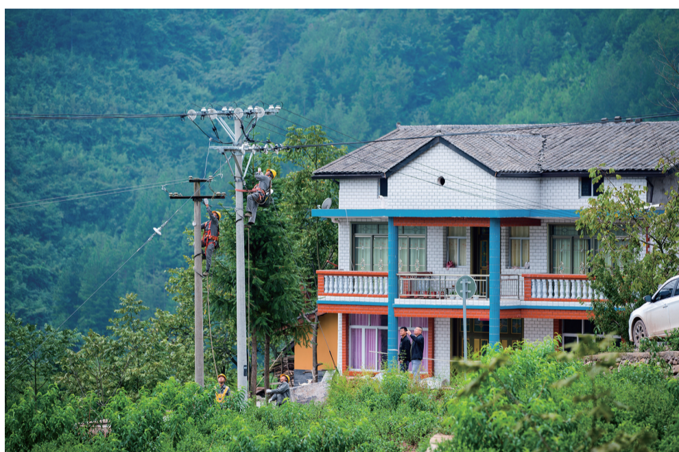
国网石柱供电公司员工为中益乡升级改造低压线路 陈健 摄/视觉重庆
