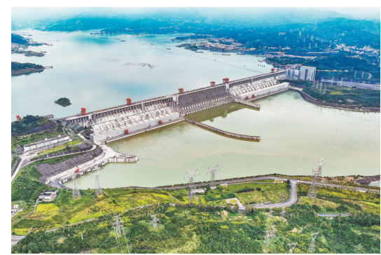
9月27日，在湖北省宜昌市秭归县拍摄的三峡大坝及三峡电站（无人机照片）。 新华社发
