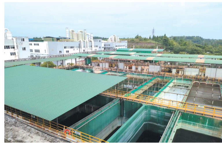
循环化改造—环保电镀产业园一体化项目
