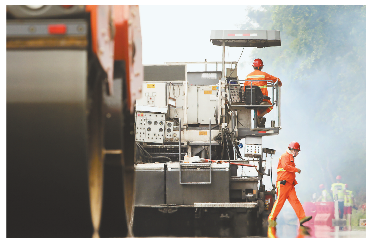
▲近日,绕城高速青木关段,重庆高速集团通力公司的养护工人,冒着高温对路面进行翻新。 记者 罗斌 摄/视觉重庆
